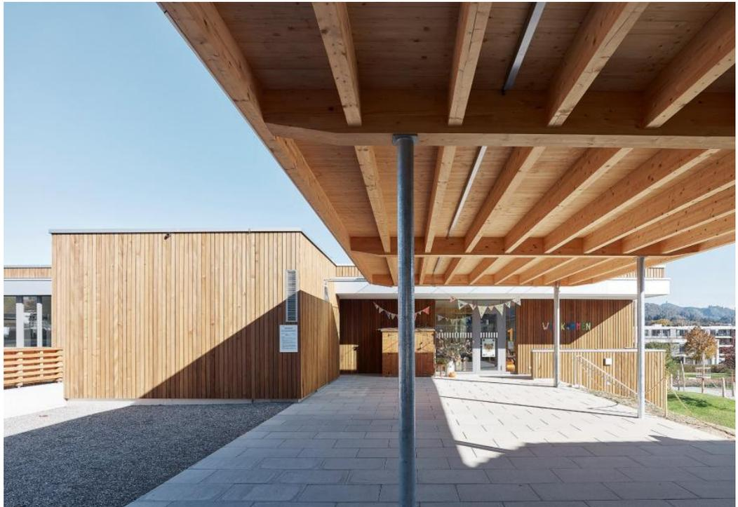
Fassade/Konstruktion – Fassade Holz Fichte geölt / hinterlüftet / Fassadenelemente
