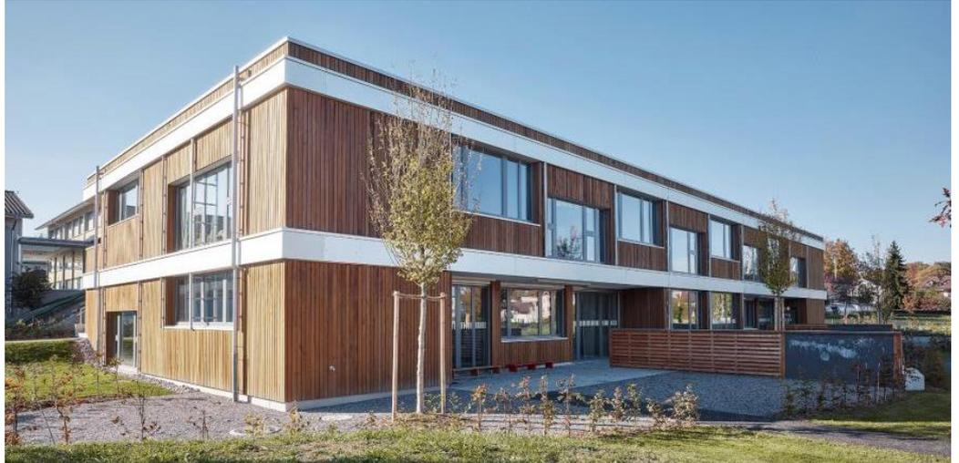
Fassade/Konstruktion – Fassade Holz Fichte geölt / hinterlüftet / Fassadenelemente
