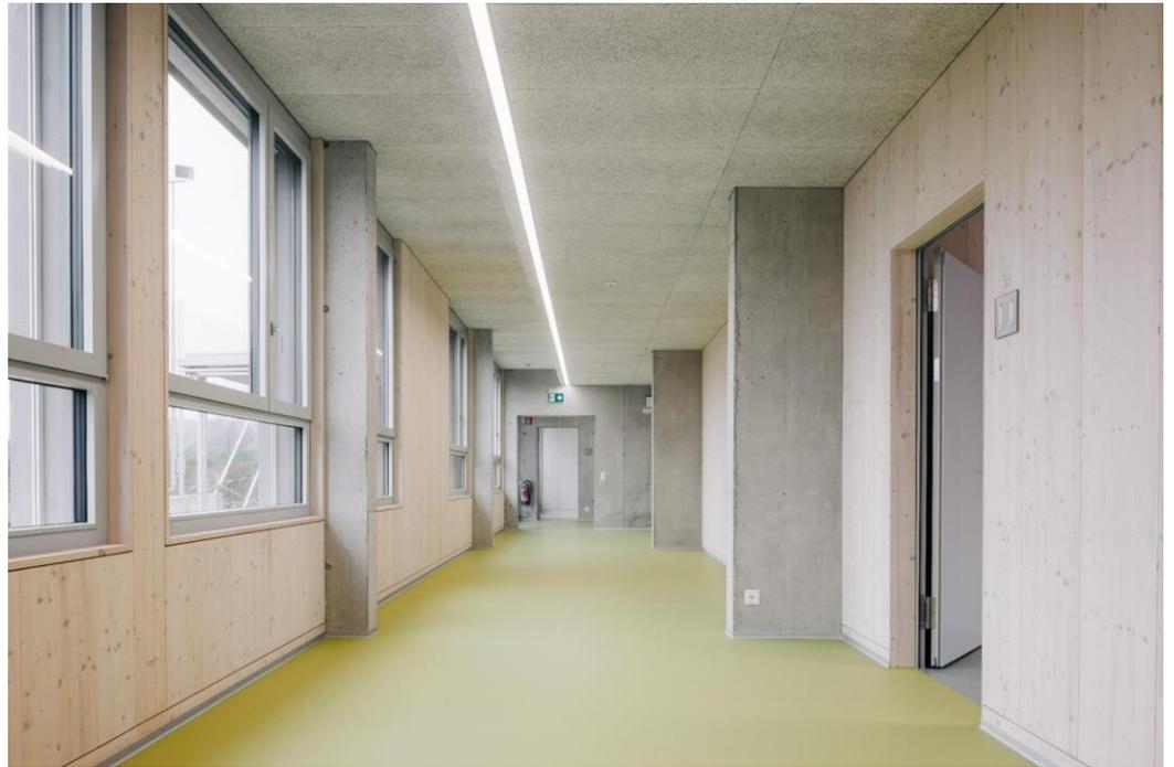
Korridor – Decke Heradesign Superfine / Wände DSP / Tragende Wände Beton
