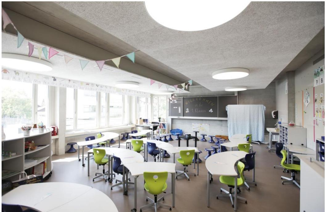
Unterricht – Decke Heradesign Superfine / Wände DSP / Tragende Wände Beton
