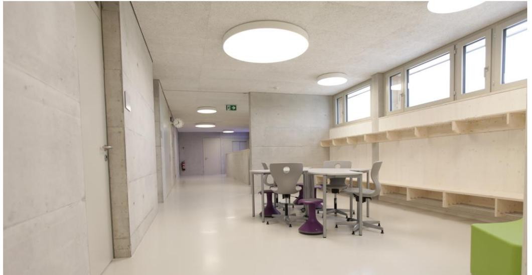
Korridor – Decke Heradesign Superfine / Wände DSP / Tragende Wände Beton
