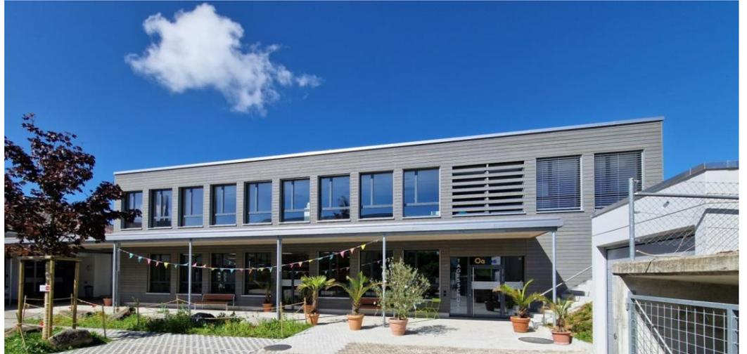
Fassade/Konstruktion – Fassade Holz vorvergraut / hinterlüftet / Fassadenelemente
