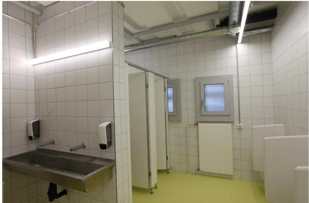
WC-Anlagen – Ersatz der Haustechnik / Apparate / Plattenarbeiten / Lüftungsanlage für geschlossene Räume / Installationen AP / keine Deckenverkleidung / neuer Boden auf bestehenden Plattenbelag
