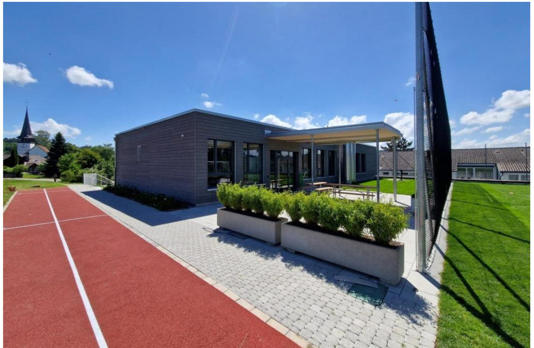
Fassade/Konstruktion – Fassade Holz Fichte geölt / hinterlüftet / Fassadenelemente
